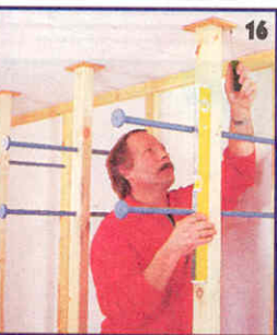
16 Для хранения пиломатериалов служит стеллаж, стойки которого (сечением 50x70 мм) в верхней части связаны металлическими штырями \varnothing 20 мм, образующими своеобразные полки.
