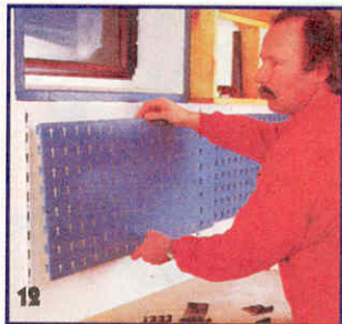
12 На шурупах крепят к стенам несущие шины для навески перфорированных щитов. Щиты окрашивают в тон стенам мастерской.
